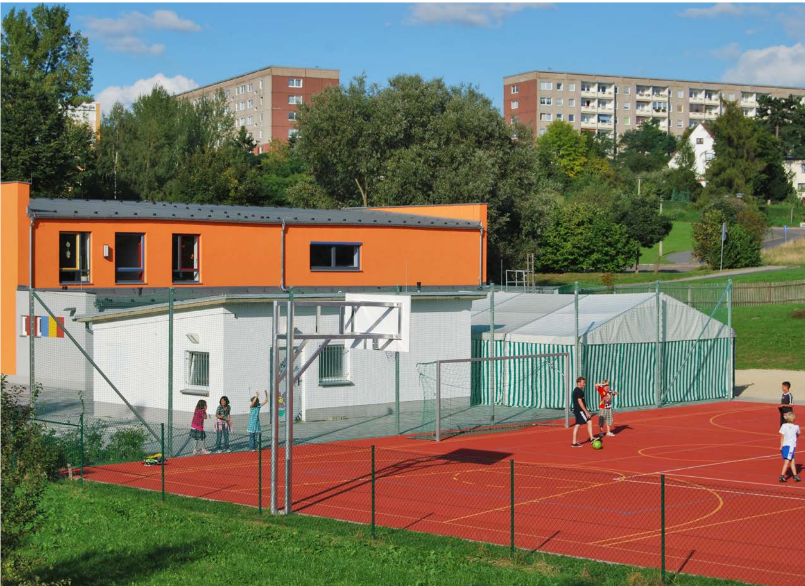
Mit der Transformation des ehemaligen Pumpwerkes wurde ein Ort geschaffen, an dem die Jugendlichen ihren Bewegungsdrang austoben können, ohne zu stören. Und ganz nebenbei wird gerade im Spiel und Mannschaftssport soziale Kompetenz entwickelt.
