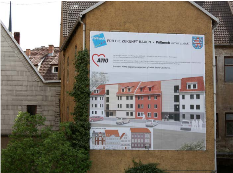
Vorerst nur ein Bauschild, aber die Bauarbeiten sind in vollem Gange.
