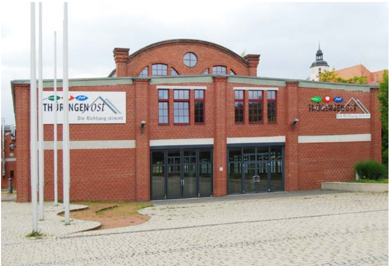
Vom brachgefallenen Industriebau zum kulturellen Zentrum der Region: die Bogenbinderhalle bietet Raum für unterschiedlichste Veranstaltungsformate.
