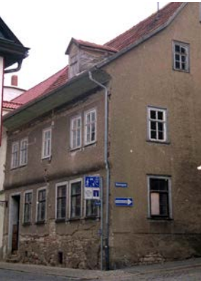
Durch die Sanierung konnte die geschlossene Straßenraumkante mit durchgängiger Trauflinie erhalten werden. Gauben machen auch das Dachgeschoss zum vollwertigen Wohnraum.
