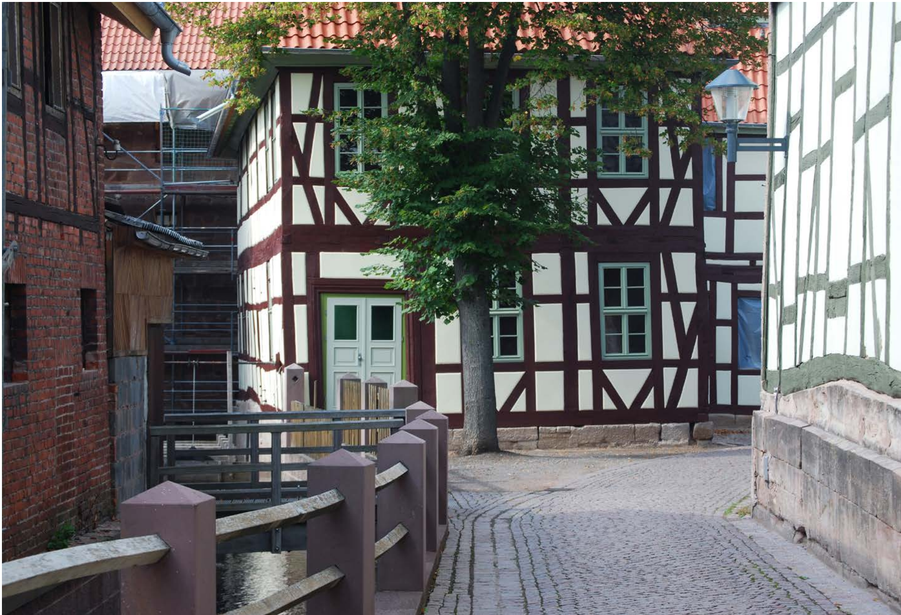
Sach- und fachgerechte Sanierung von Fachwerk und Natursteinmauern; gute Architekten und Handwerker können auch mit Verformungen und Bauschäden umgehen.
