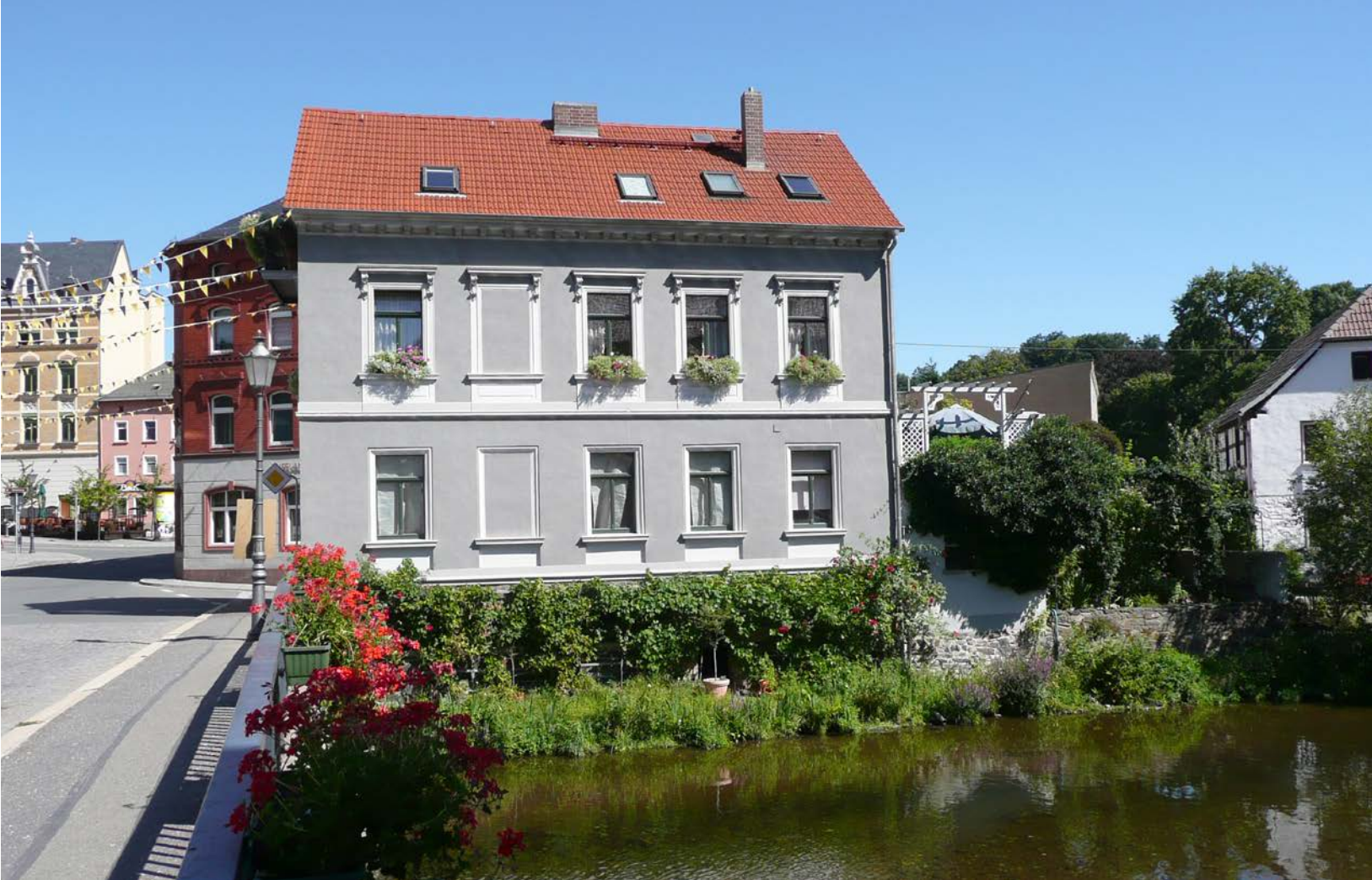
Mit der Aktion „Weida lückenlos“ bringt die Stadt Häuser und Investoren zusammen, um Sanierung und nachhaltige Nutzung zu ermöglichen; im Einzelfall geht sie selbst mit gutem Beispiel voran. Der Erfolg setzt sich aus vielen kleinen Mosaiksteinen zusammen. Ein mühsames Geschäft, aber gibt es eine Alternative?
