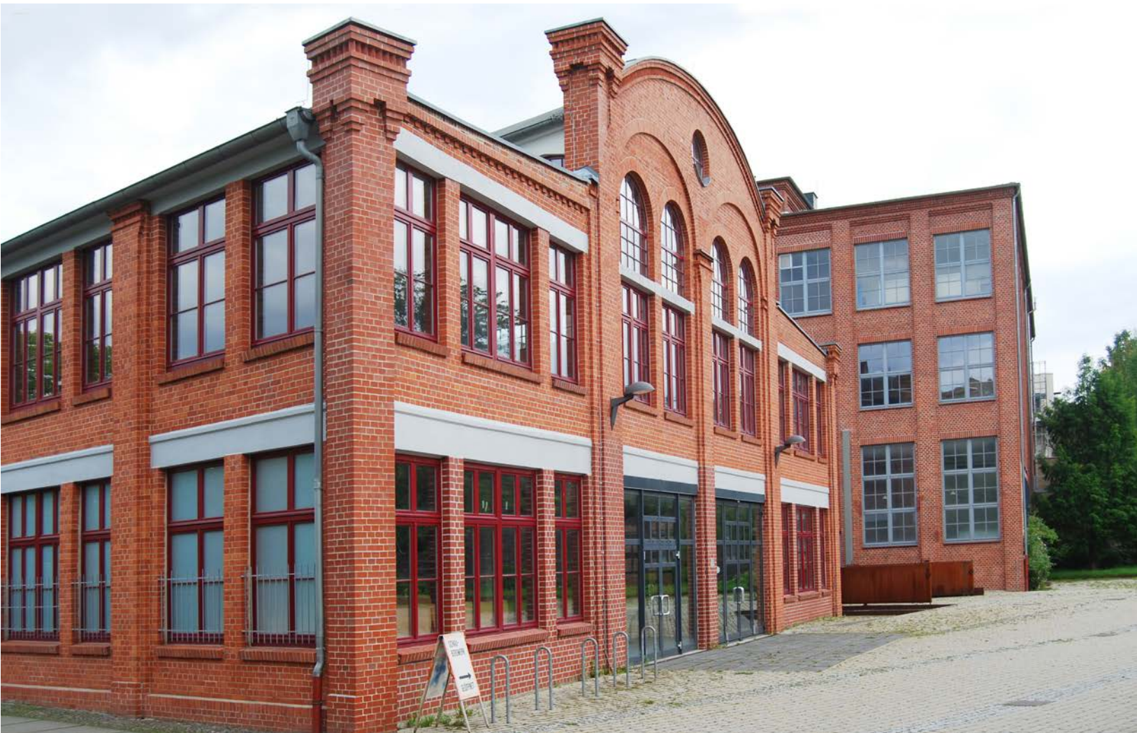
Die denkmalgerechte Sanierung verdeutlicht den Mut und die Pionierleistung der Ingenieure im Umgang mit Stahlbeton.
