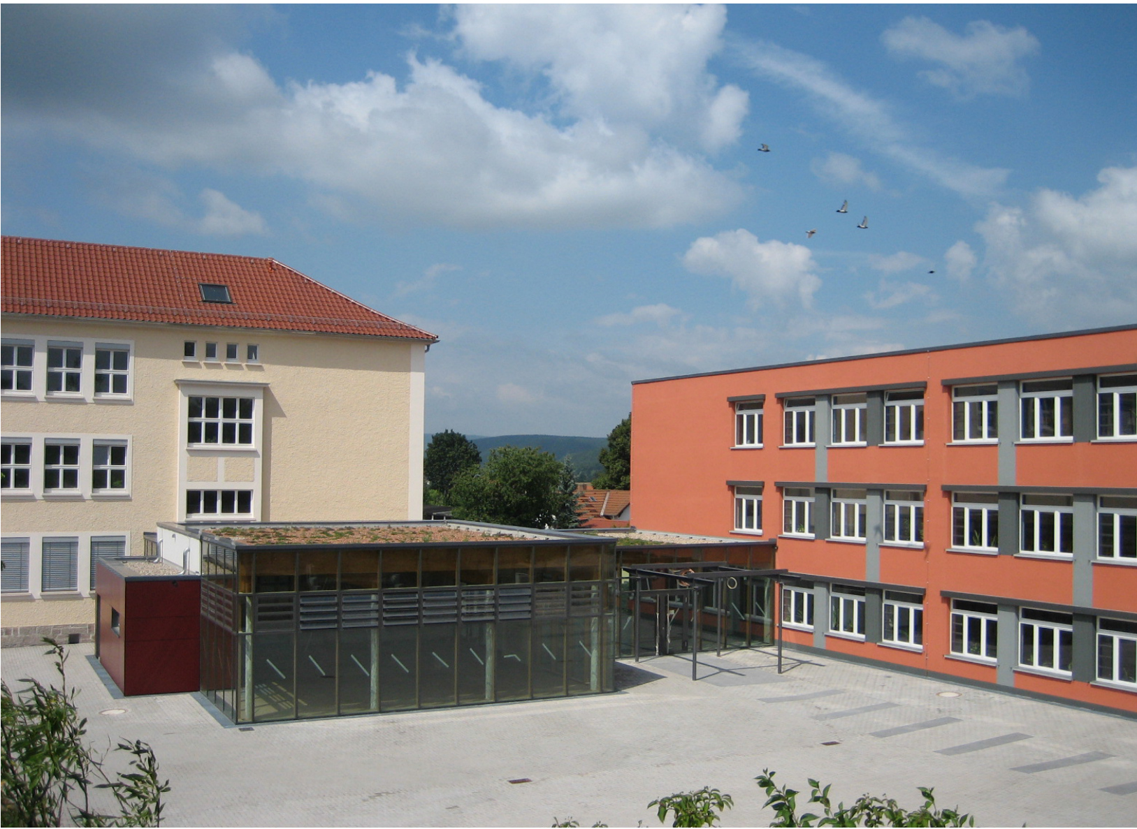
Nach dem Umbau bietet die Schule alles, was zu einem modernen Ganztags-Schulbetrieb gehört.
