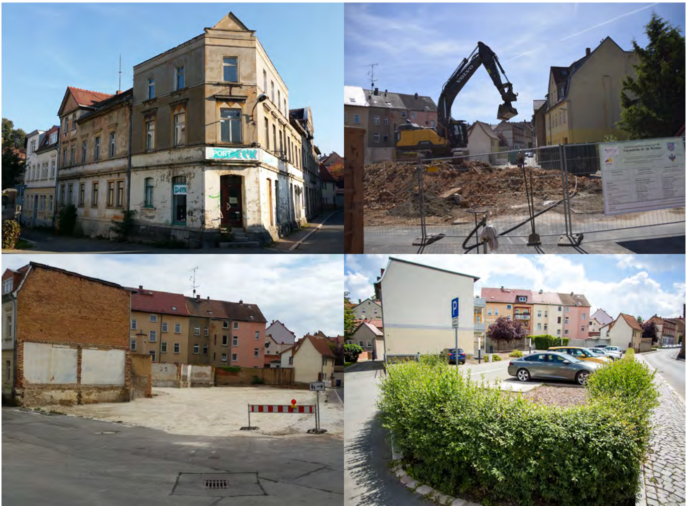
Abb. 16: Fabrikstraße 24/26 – Links oben: Ursprungszustand. Rechts oben: Abrissmaßnahme 2017. Links unten: Abrissfläche. Rechts unten: Neu entstandener Parkplatz mit unterirdischer Löschwasserzisterne nach Nutzungszuführung 2024.
