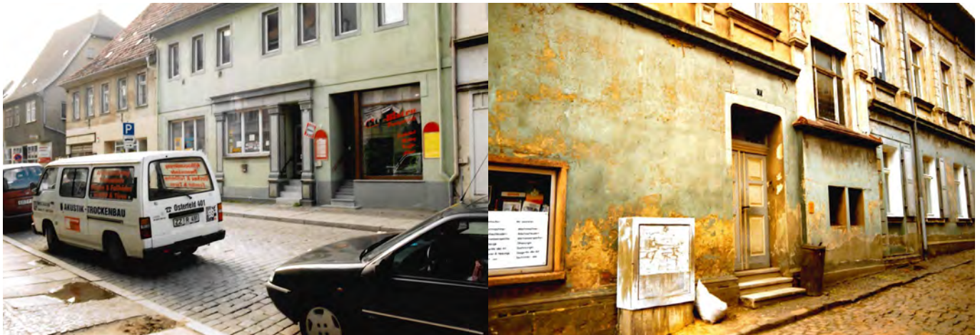
Abb. 12: Links: Zustand des Steinwegs 1992. Der sanierte Steinweg ist auf Abb. 24 zu sehen. Rechts: Zustand Steinweg/Johannisgasse 1992.
