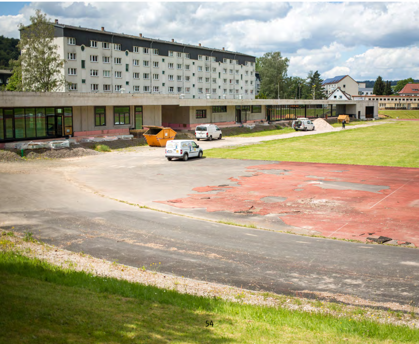
Abb. 54: Rohbau des neuen Stadiongebäudes, 2024 Foto: GRAS*
