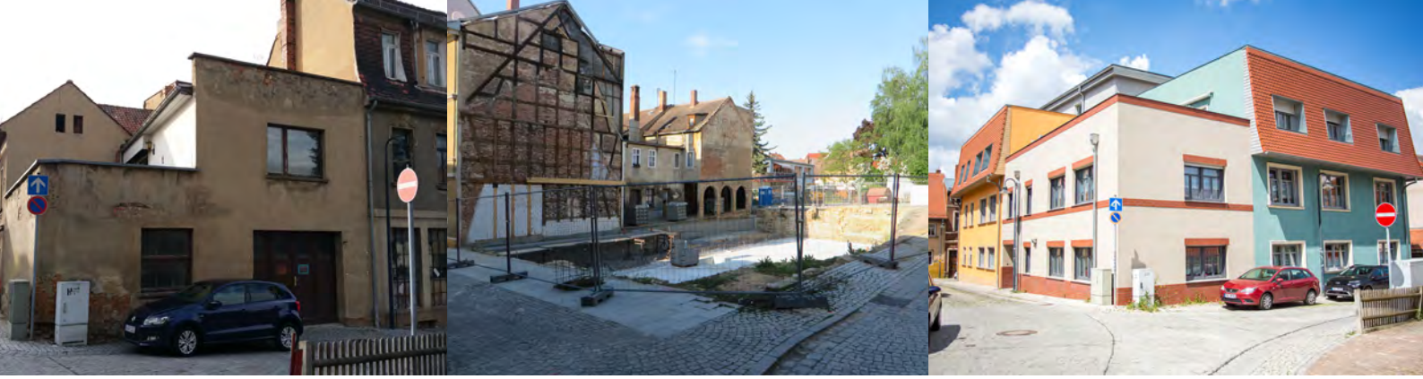
Abb. 19: Mauergasse/Wächtergasse. Links: Ursprüngliche Immobilie. Mitte: Fundament nach dem Abriss 2017. Rechts: Ersatzneubau mit integriertem Aufzug und Dachterrasse, 2024.
