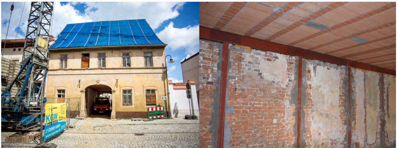
Abb. 20: Gebäude mit einem gescheiterten Hospizkonzept wird nach jahrelangem Verfall nun gesichert und zu hochwertigem Wohnraum saniert, 2024
