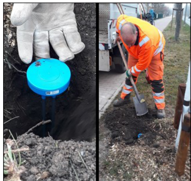
Abb. 86: Einbau der Sensoren zur Bodenfeuchtemessung. Quelle: Stadtverwaltung Jena
