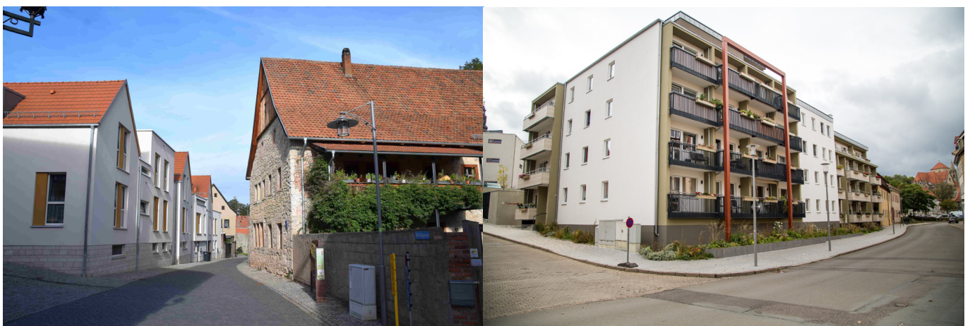
Abb. 8: Links: Alt trifft neu – städtebaulicher Kontrast zwischen Wohnen im Kloster (rechts) und neugebauten Brunnenhöfen (links) in Arnstadt. Rechts: Sanierter Block an der Töpfergasse/An der Weiße in Arnstadt.
