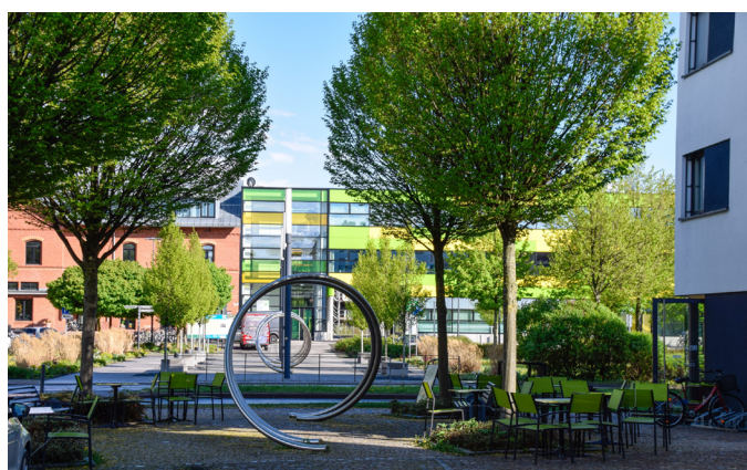
Abb. 11: Saniertes Bahnhofsgebäude mit gestaltetem Übergang zur Altstadt in Ilmenau.
